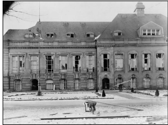
(3) Das durch die Explosion stark beschädigte Verwaltungsgebäude Q 26 (Ostseite)
