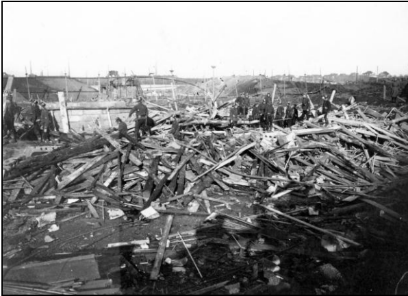
(2) Feuerwehrleute durchsuchen den zerstörten Aufenthaltsraum der Arbeiter
