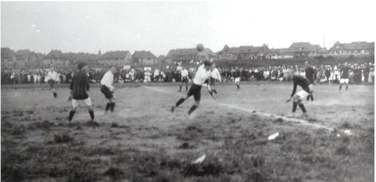
Der Dhünnplatz (im Hintergrund die Häuser der Kolonie II an der Adolfsstraße und am Nordring, der heutigen Albert-Einstein-Straße)
