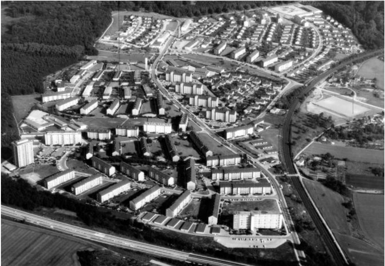
Die Siedlung Alkenrath von Norden gesehen (Aufnahme aus dem Jahre 1967)
